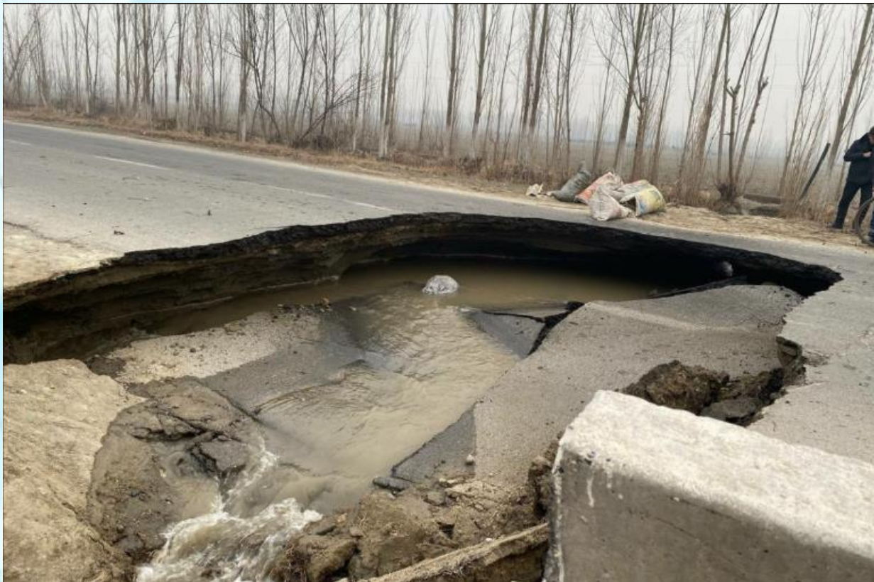
2-rasm. Fargʻona viloyatidagi yoʻlning suv taʼsirida buzilishi
