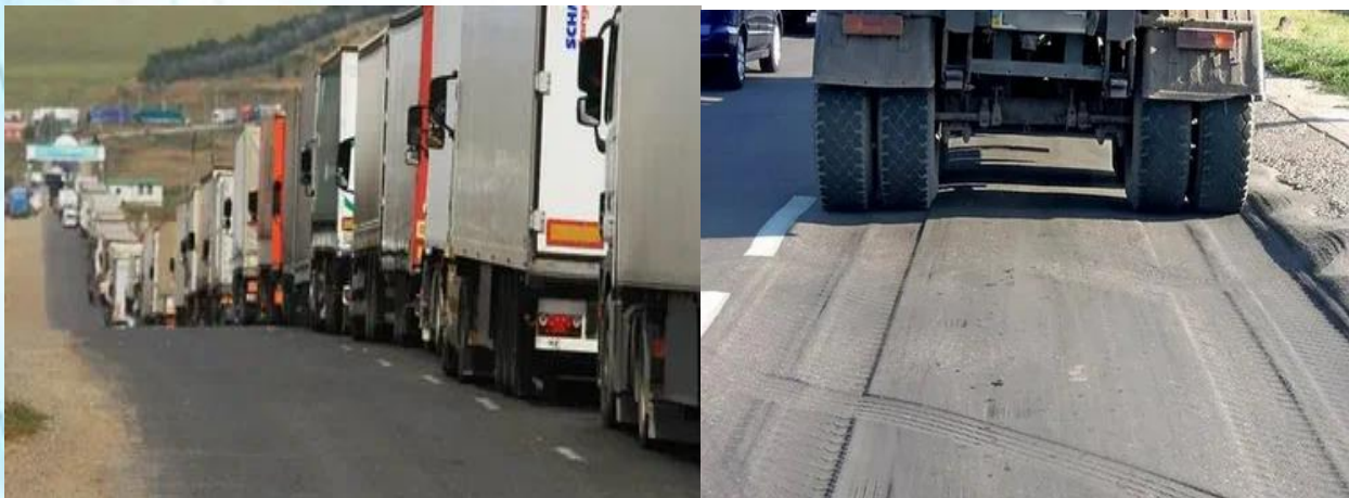
3-rasm. Avtomobil yo‘llarida og‘ir yuk tashish oqibatlari.
