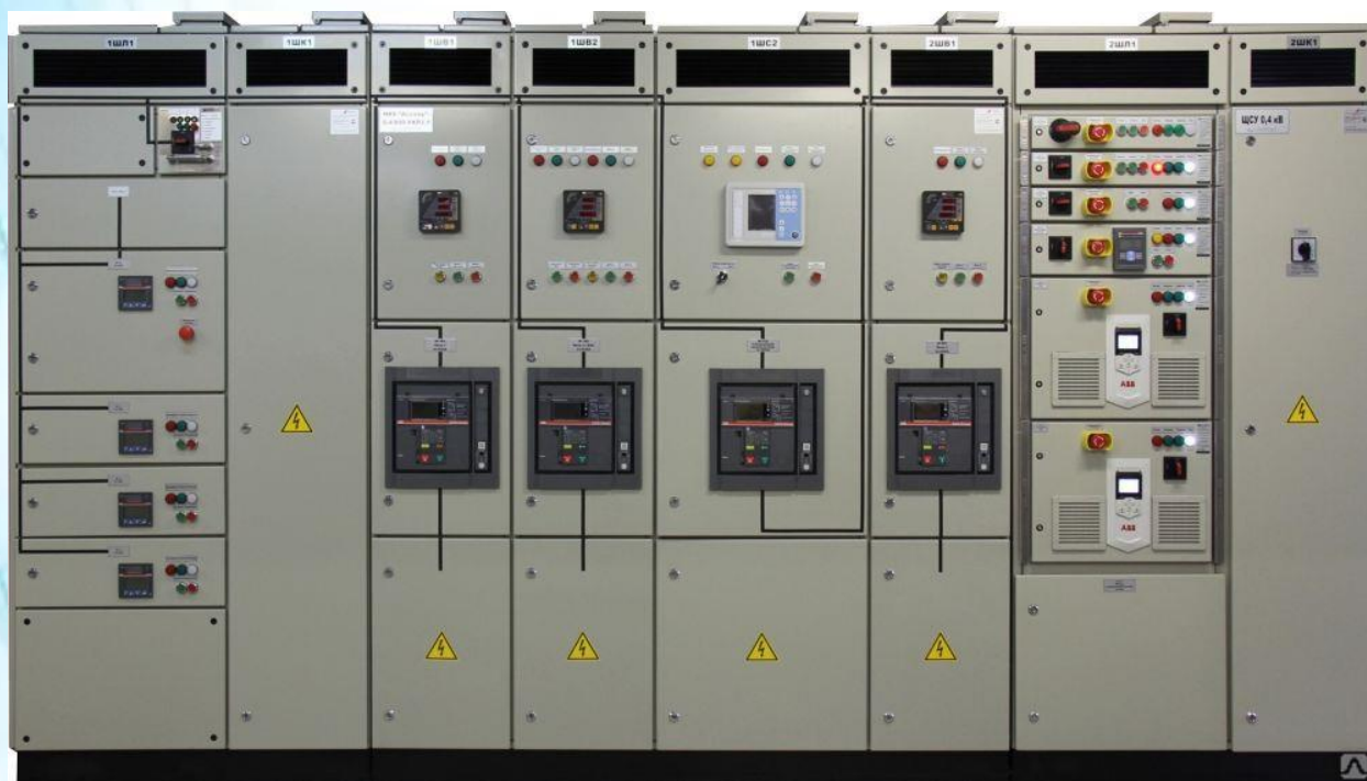
1-rasm. Past kuchlanishli kompleks boshqaruv qurilmasi
