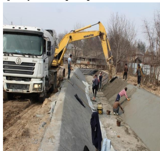
2 -rasm. Kanalni betonlashtirishning bugungi kundagi holati
