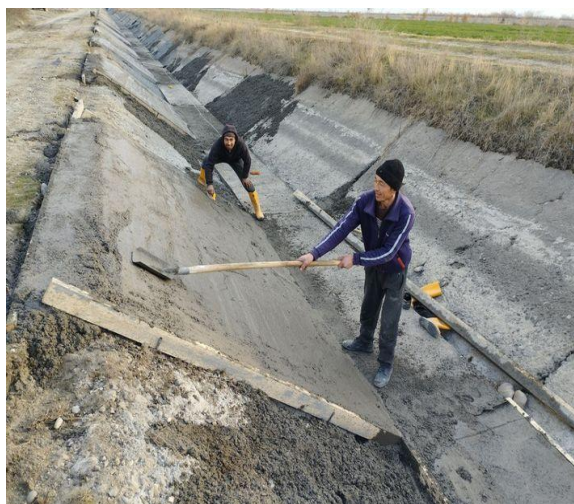
2 -rasm. Kanalni betonlashtirishning bugungi kundagi holati
