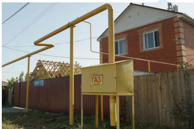
2 – rasm. Aholi turar joy binolariga oqim gaz quvurlarining o‘rnatilishi
