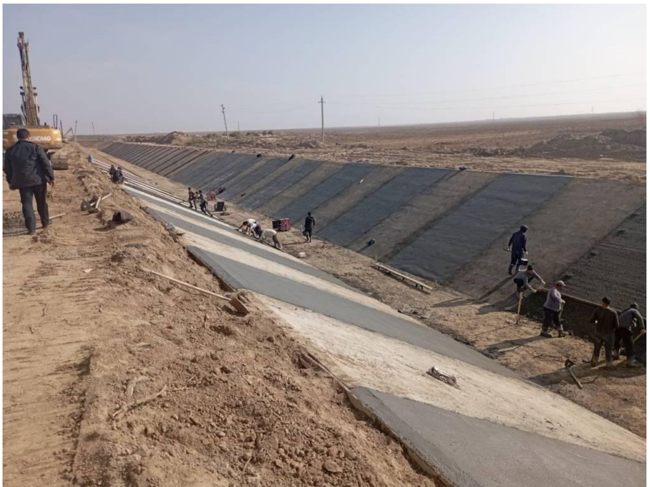
1-rasm. R-26 kanalini betonlashtirish jarayoni
