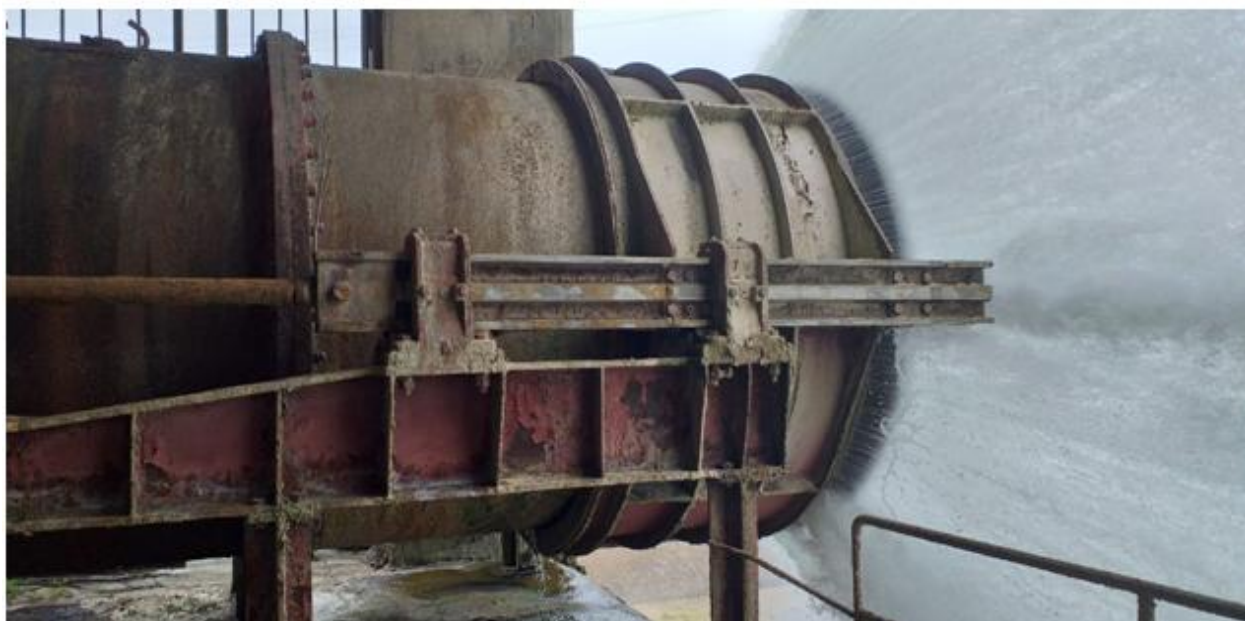
1-rasm. Suv oqimining erkin yuzasi bilan gazni jalb qilish
