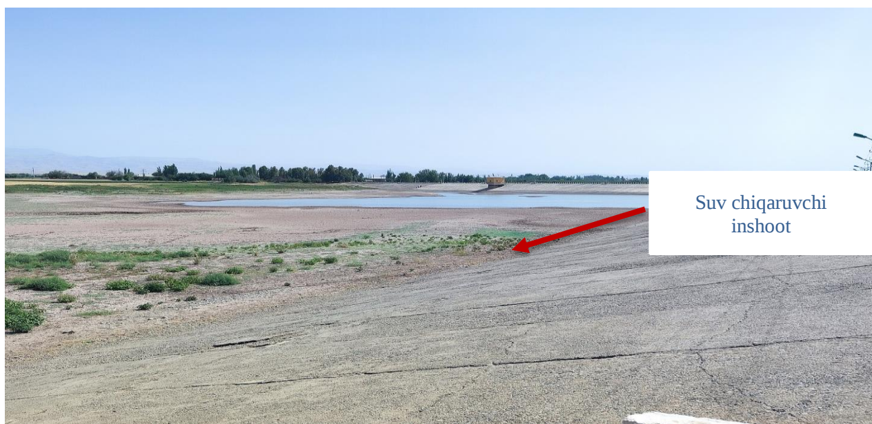
1.2-rasm. Nug'ayli suv omborining umumiy ko'rinishi
