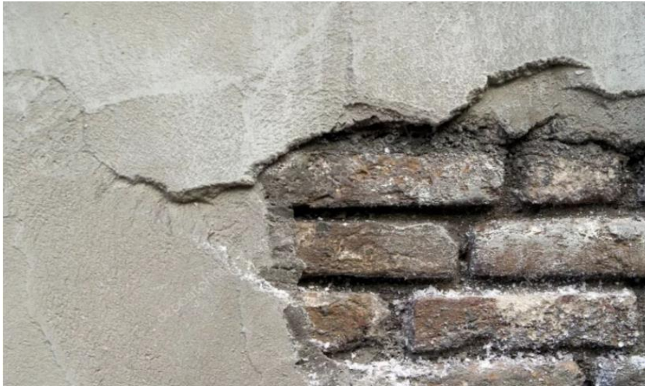
1-rasm. Grunt namligidan namlangan tashqi devor
